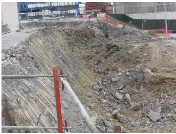
Figura 4. A la izquierda, talud generado durante la excavación
