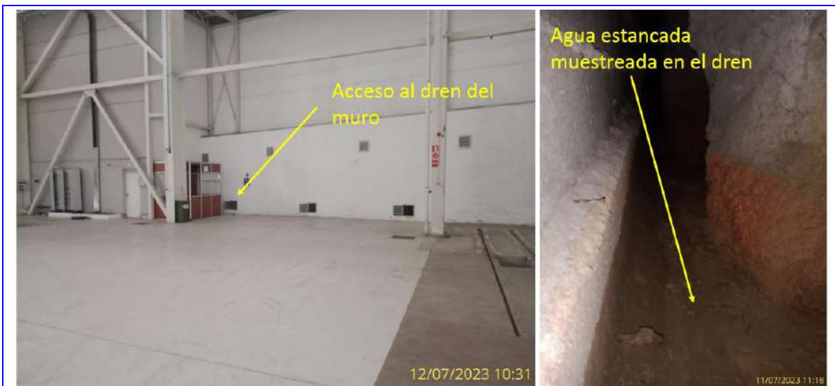
Figura 6. Muestreo del agua en el dren del muro
