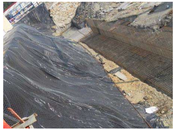
Figura 5. A la derecha, construcción del muro de contención
