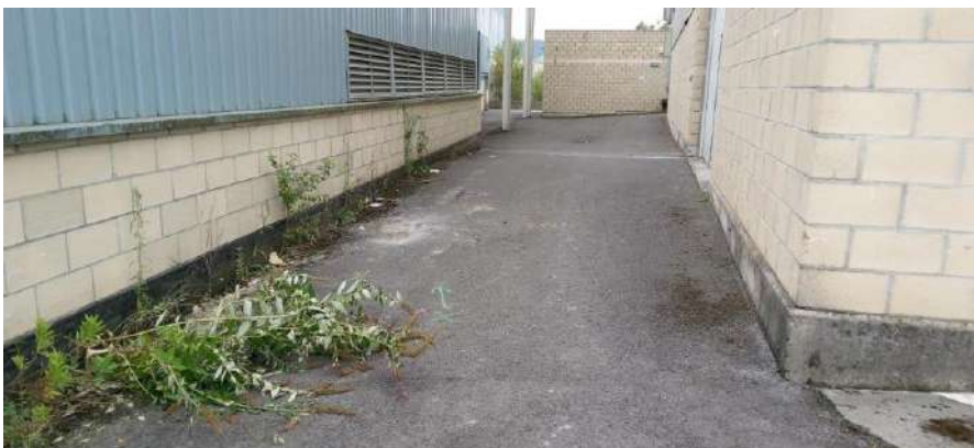
Figura 2. Zona exterior este
